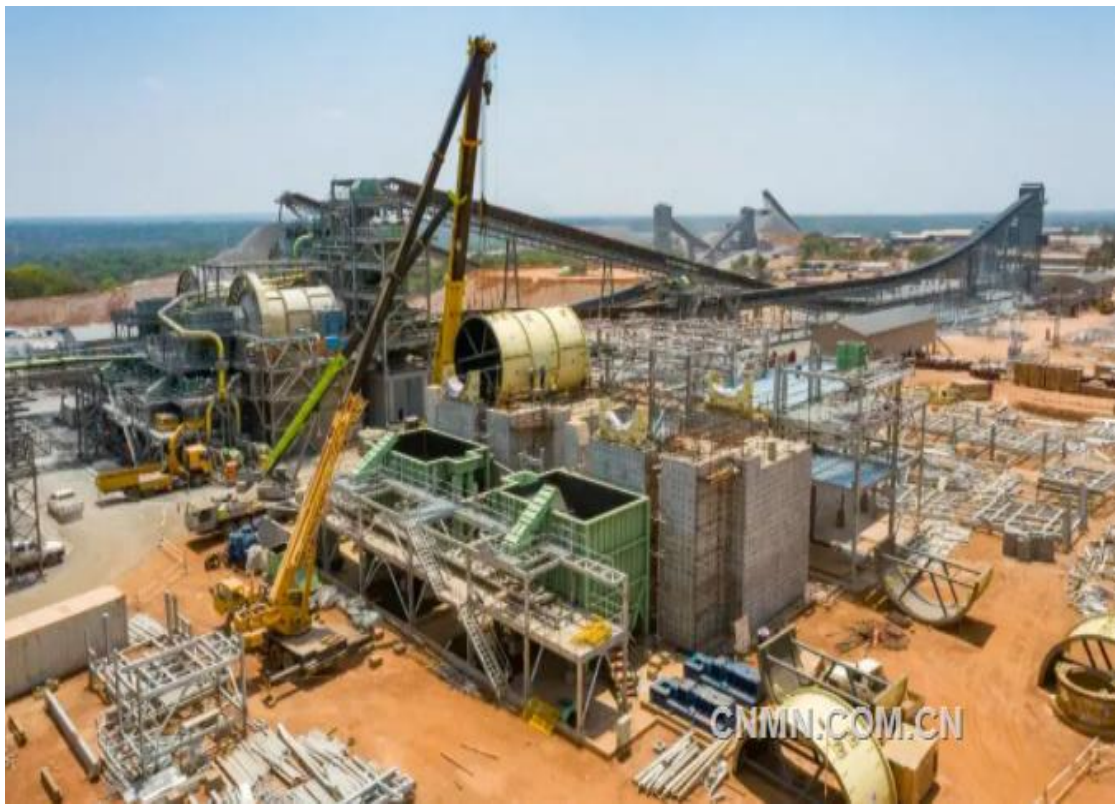
刚果（金）卡库拉铜矿二期项目球磨机安装现场
